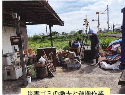
災害ゴミの撤去と運搬作業
